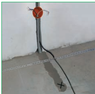
◀ Начало укладки кабеля Весь кабель уложен
