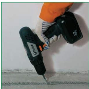
▲ Закрепить монтажную ленту
