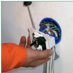
▲ Подключение терморегулятора
