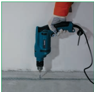
▲ Просверлить отверстие
